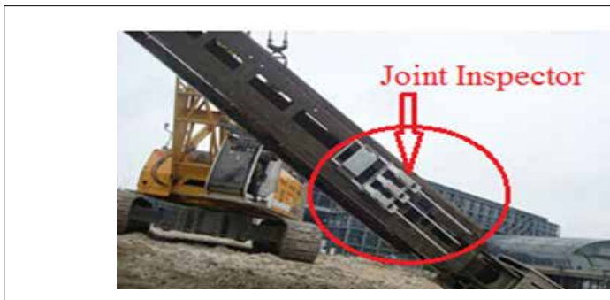
Hình 7: "Joint Inspector" được gắn trên gầu ngoạm
