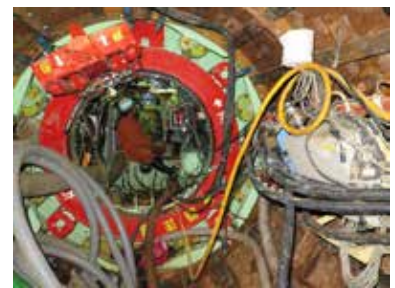
Hình 6 – Ví dụ về bố trí không gian thao tác tại đầu khoan
