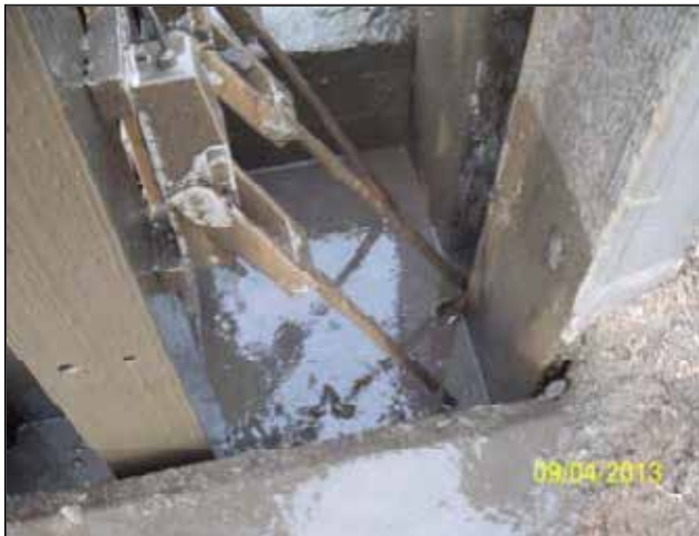
Hình 8: "Joint Inspector" tiếp cận mối nối
