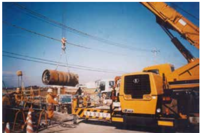
Hình 4 – Ví dụ về việc phối hợp vận hành trong thi công
